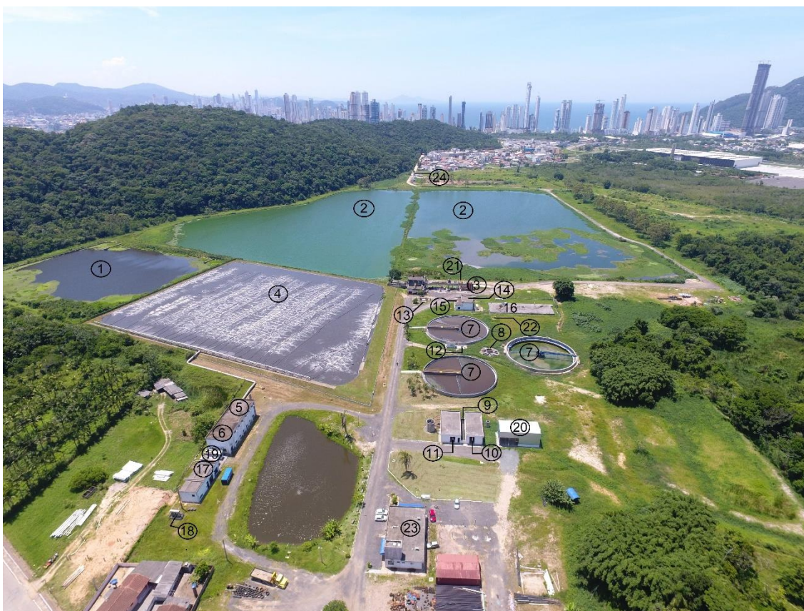
Figura 2 - Vista aérea da área da ETE
